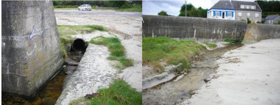
Figure 2 : Exutoire du ruisseau du Château sur la plage
